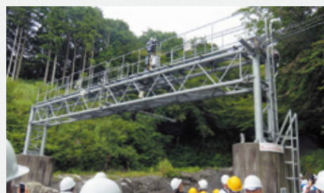
▲岩樋水位流量観測所の見学 (2P 大沢扇状地見学会より)
